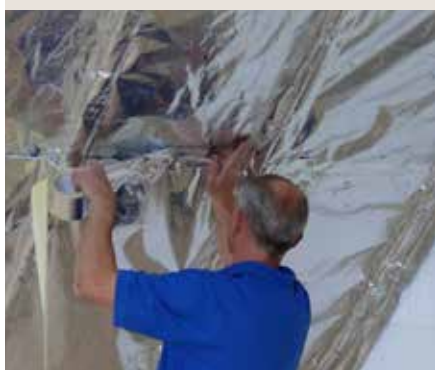
SuperQuilt moet worden aangebracht met een overlap van minimaal 50 mm en daarna worden dichtgeplakt met YBS Foil Tape.
